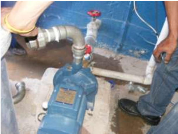
Nuwe waterpomp word by suiwerstelsel installeer
